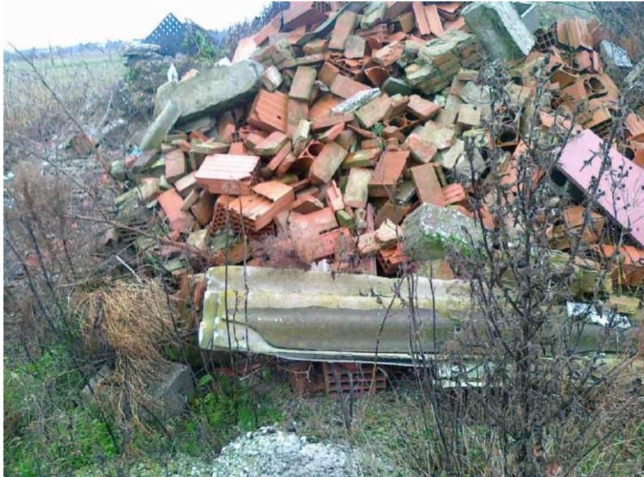
**Azioni immediate da far eseguire: messa in sicurezza mediante copertura del cumulo per presenza di copertura in fibrocemento, che può contenere AMIANTO.**
