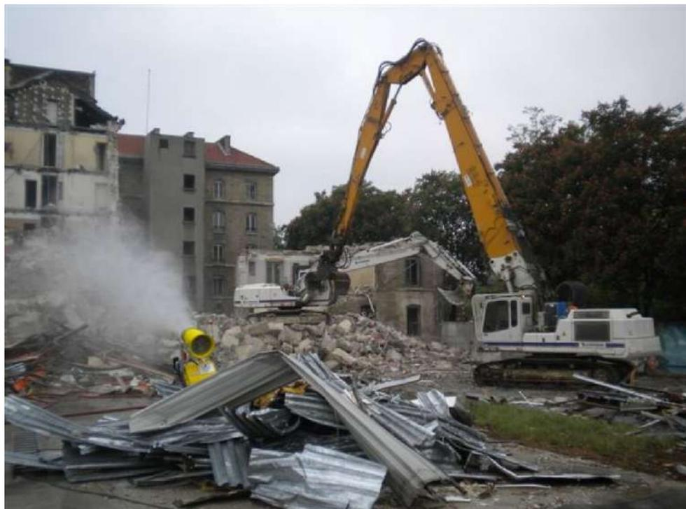
In questo caso con l'adozione di tutti i presidi atti a limitare la dispersione delle polveri in ambiente (NEBULIZZATORI DI ACQUA) si è evitato il rilascio di fibre di amianto.
