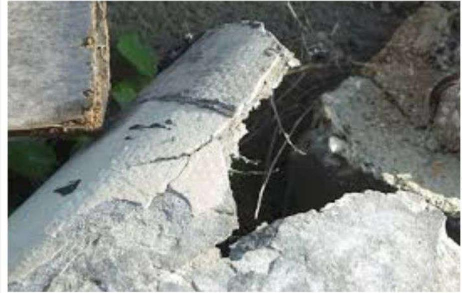
Nel caso in cui l'amianto si presenta in **MATRICE FRIABILE**, quindi il manufatto sia in stato di degrado **può diventare pericoloso**, qualora lo stato di degrado risulti essere superiore al 10% della superficie totale o in presenza di rifiuti contenenti AMIANTO, si dovrà procedere alla bonifica.
