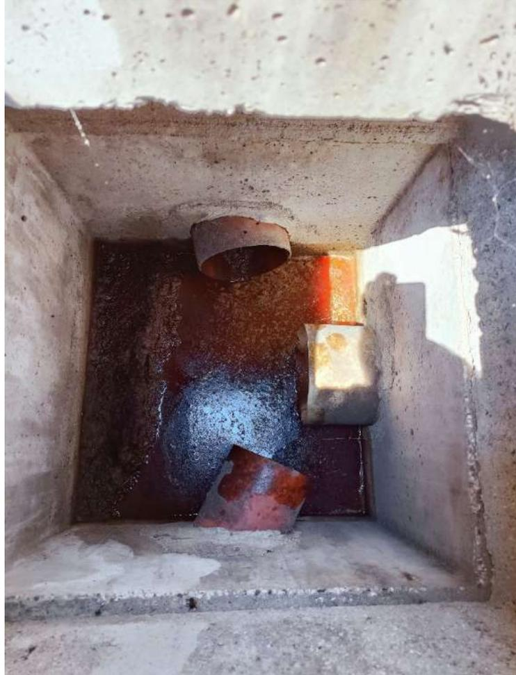
**Punto di scarico della miscela acqua ed olio, di origine abusiva, nel pozzetto allacciato con la fognatura pubblica e con successivo recapito nel corso d'acqua superficiale**
